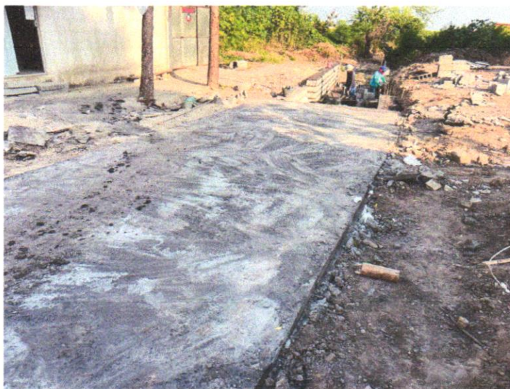
FOTO 03 - PAVIMENTAÇÃO EM CONCRETO, COM ESPESSURA DE 7 CM, COM ACABAMENTO FEITO UTILIZANDO ALISADORA DE CONCRETO (HELICOPTERO), INCLUIDO TELA DE AÇO SOLDADA NERVURADA CA60
