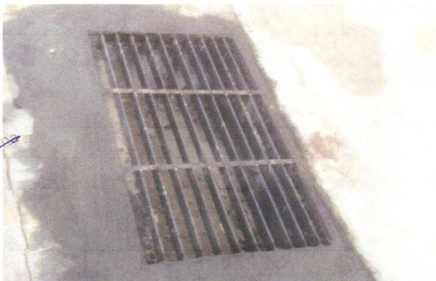
16 -(FORNECIMENTO E ASSENTAMENTO DE GRELHA DE (0,30 X 0,90 M)
