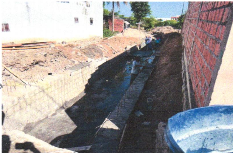
18-ESCAVAÇÃO MANUAL DE VALA COM PROFUNDIDADE MENOR OU IGUAL A 1,30 M
