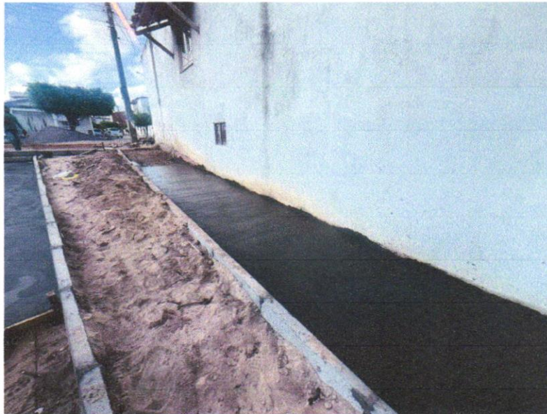
FOTO 01 - PAVIMENTAÇÃO EM CONCRETO, COM ESPESSURA DE 7 CM, COM ACABAMENTO FEITO UTILIZANDO ALISADORA DE CONCRETO (HELICOPTERO), INCLUIDO TELA DE AÇO SOLDADA NERVURADA CA60
