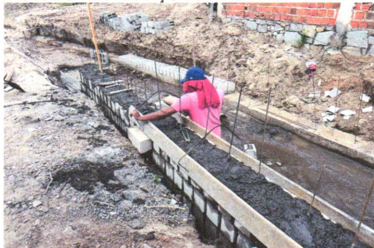
FOTO 02 - LASTRO DE CONCRETO, E=5CM, PREPARO MECÂNICO, INCLUSOS LANÇAMENTO E ADENSAMENTO
