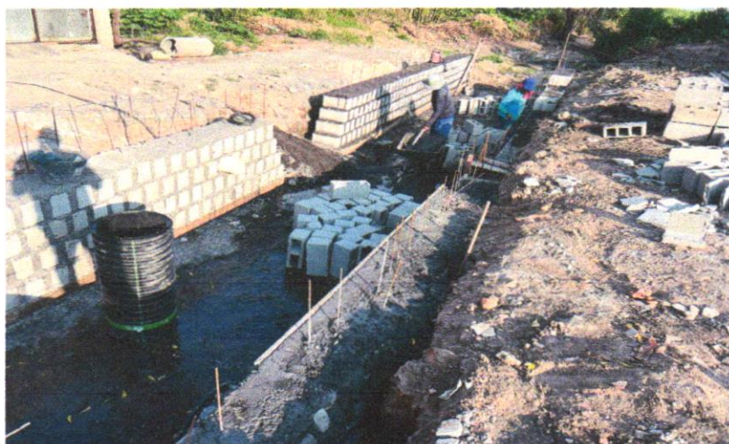
FOTO 12 -LASTRO DE CONCRETO, E=5CM, PREPARO MECÂNICO, INCLUSOS LANÇAMENTO E ADENSAMENTO
