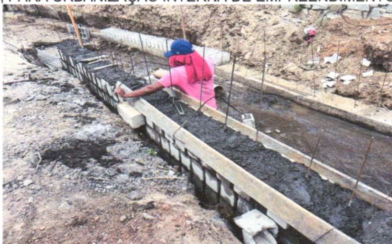
FOTO 10 -LASTRO DE CONCRETO, E=5CM, PREPARO MECÂNICO, INCLUSOS LANÇAMENTO E ADENSAMENTO
