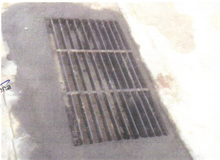
13 -FORNECIMENTO E ASSENTAMENTO DE GRELHA DE (0,40 X 0,90 M)
